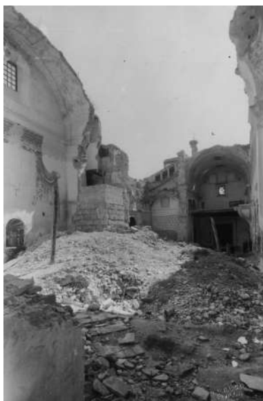
3. Vista desde la cabecera del interior de la iglesia del convento de Madre de Dios de Osuna tras el desplome de su techumbre en 1944. En el lado de la epístola se aprecia la capilla de la Concepción. Fototeca Laboratorio de Arte. Universidad de Sevilla.
